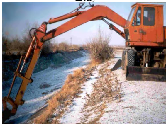
10. Очистка русла канала от наносов
