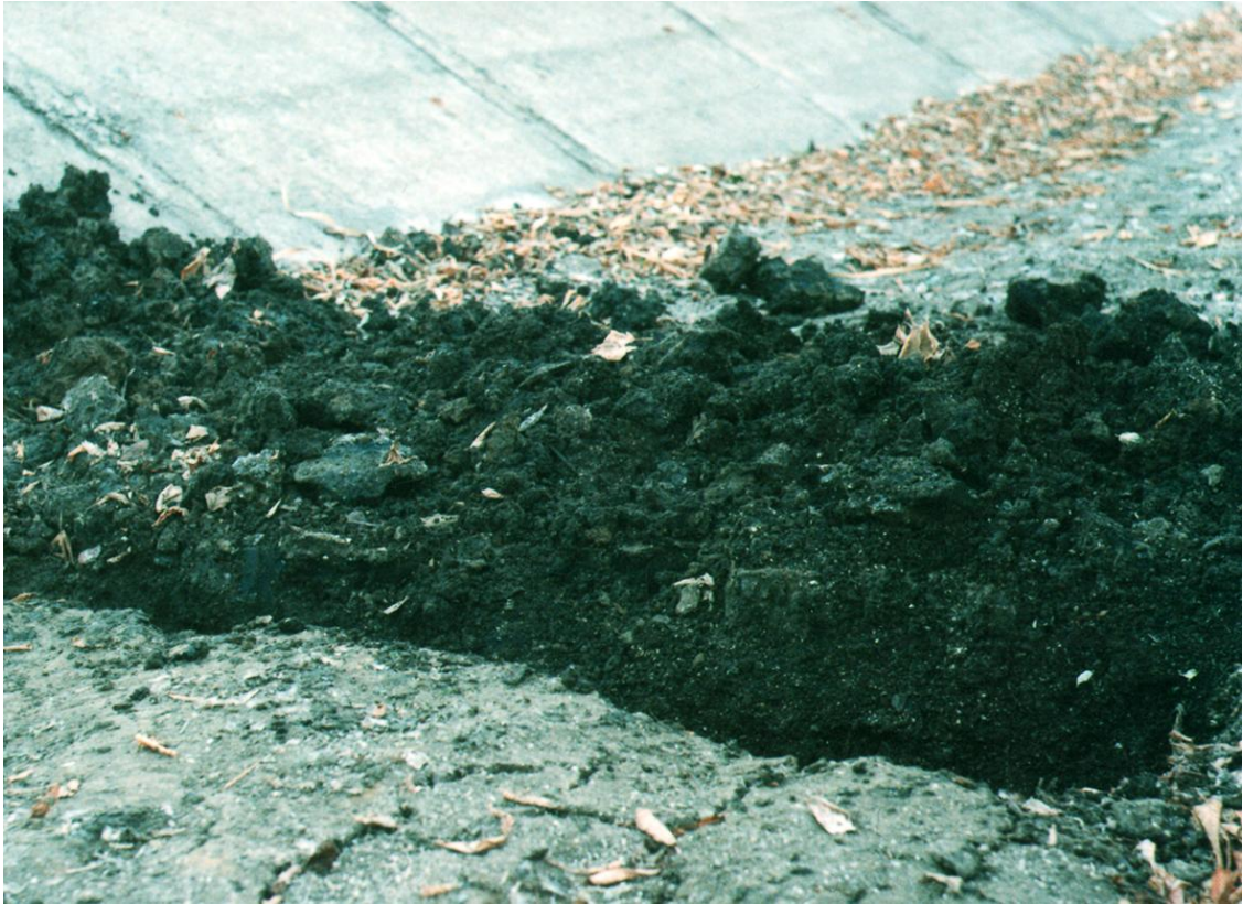
Рисунок 3.4 – Контрольный створ для измерения толщины слоя донных отложений
