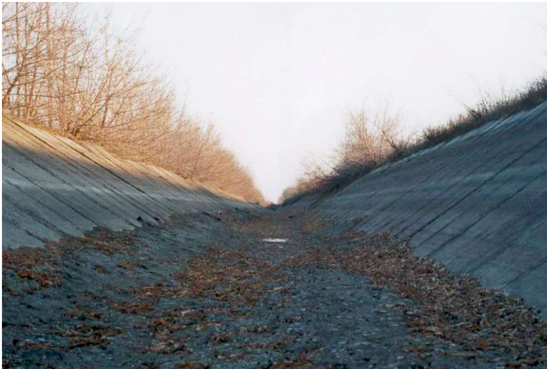
Рисунок 1.14 – Заиленный участок оросительного канала
