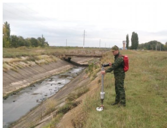
12. Доинъектирование пней на берегах и откосах канала
