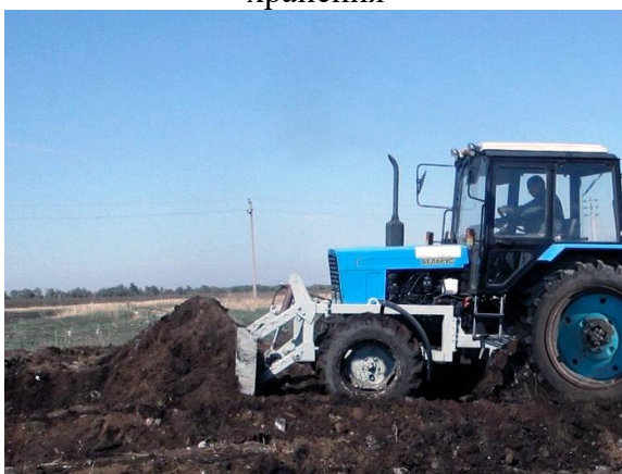
11. Разравнивание извлеченного наносного грунта
