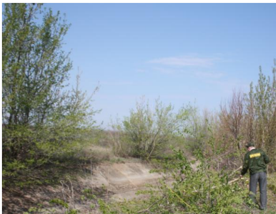
1. Визуальный осмотр поверхностей берм и откосов канала, удаление из зоны выполнения работ посторонних предметов
