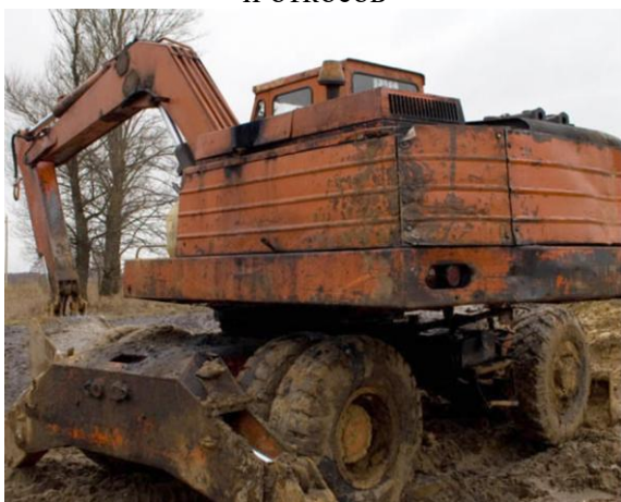
6. Очистка русла канала от наносов
