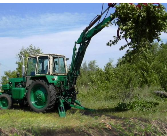
5. Извлечение срезанной растительности из русла канала с последующим ее перемещением в сформированные кучи
